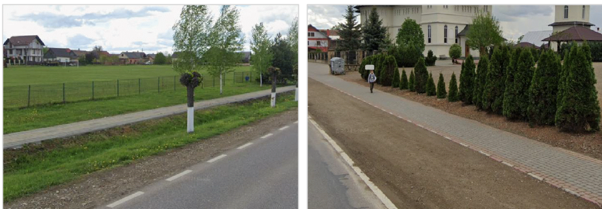
Figura 2.52. Trotuare în stare bună (exemplificare).
