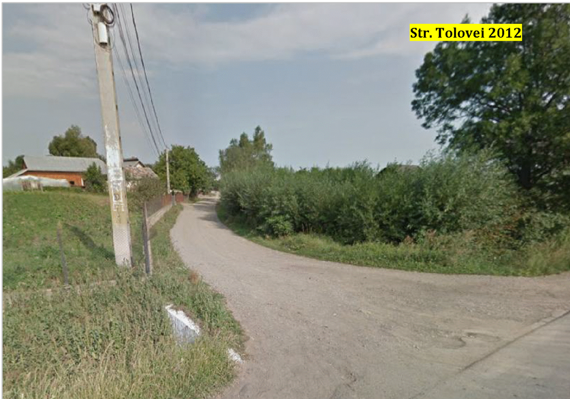
Figura 4.15. Amenajare Str. Tolovei – 2012. Sursa: Google Maps, 2024.
